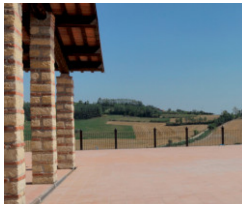
Soukromá terasa v Ceresetu (Itálie) ošetřená hydroizolací Mapelastice Zero
