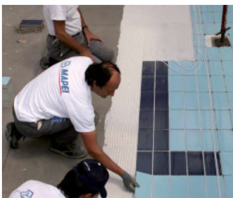
Pokládka keramické dlažby na hydroizolační vrstvu Mapelastice Zero
