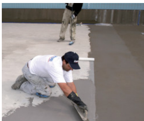
Hydroizolace bazénu výrobkem Mapelastice Zero
