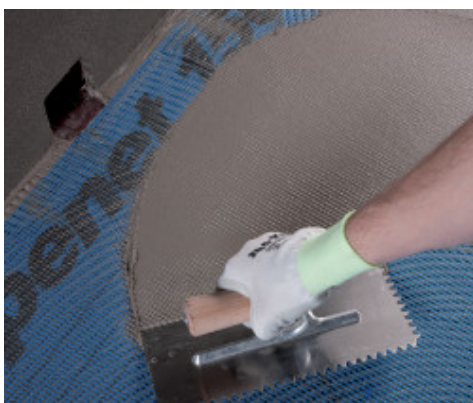
Nanášení hydroizolace Mapelastice Zero na síťovinu Mapenet 150
