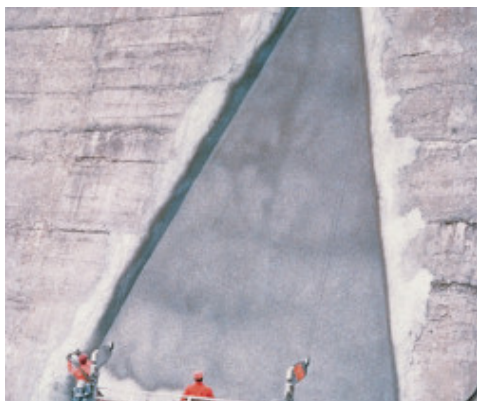
Aplikace Mapelastícu Zero nástřikem na přehradní hráz
