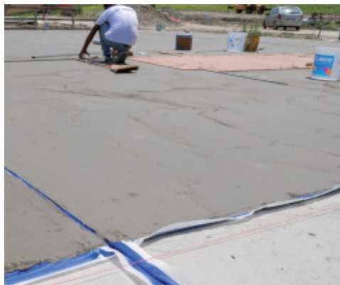
Hydroizolace povrchů Mapelasticem Zero a Mapebandem
