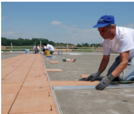
Instalace keramické dlažby s lepidlem Kerabond TE+ Isolastic
