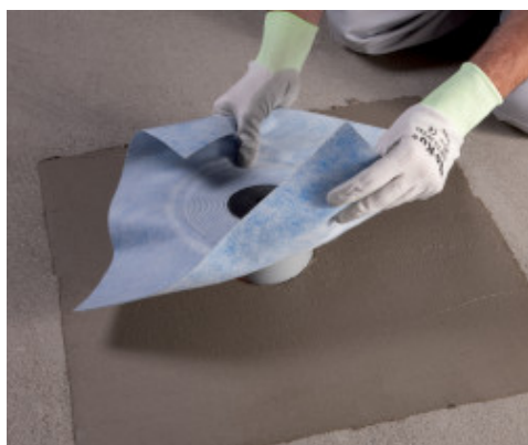
Instalace podlahové vpusti Drain Vertical na Mapelastice Zero
