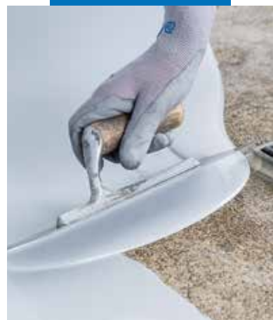
Aplikace stěrky Mapegum EPX
