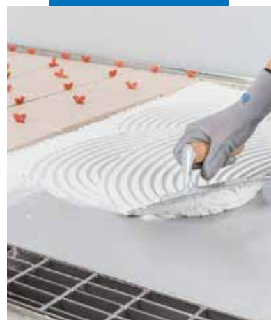
Lepení dlažby s použitím lepidla Kerapoxy Adhesive
