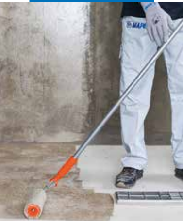
Penetrace podkladu s použitím výrobku Primer SN
