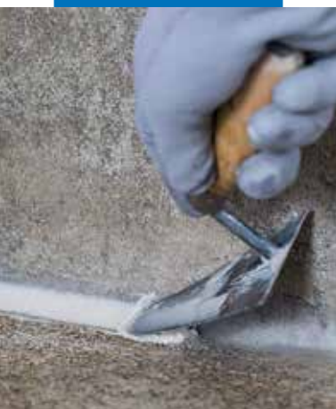
Provádění fabionu
